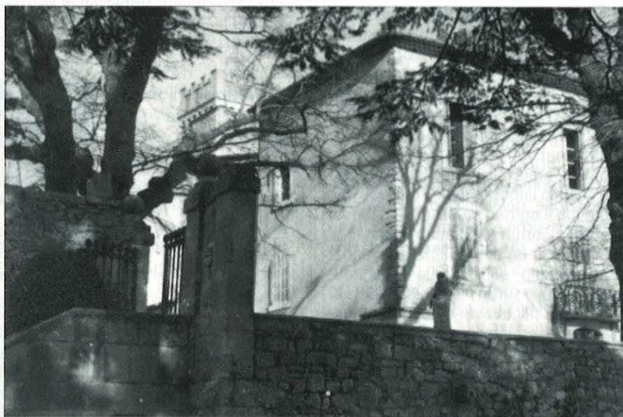
Castello di Ollières (Provenza) dove nel 1943 alloggiava la 78 a del Belluno.
